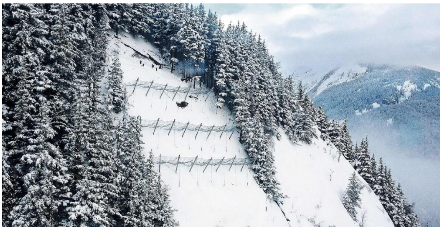
Рисунок 1.4 – Защитные сооружения от лавин в швейцарских Альпах [165]
