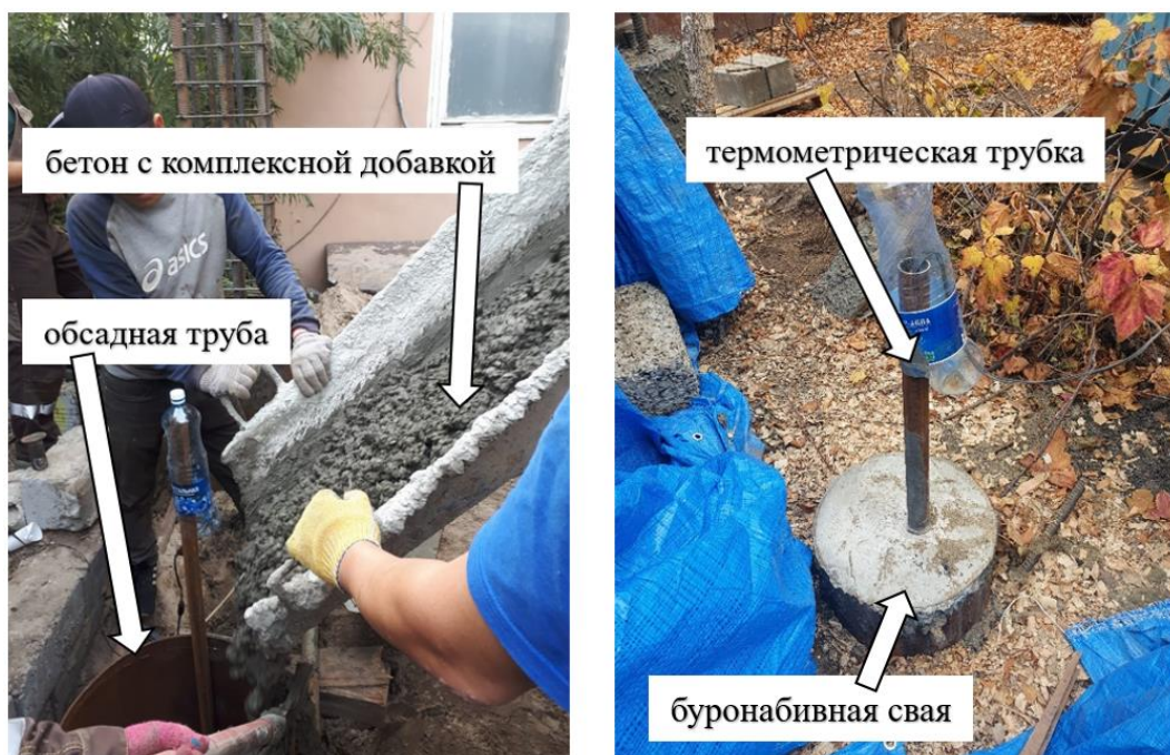
Рисунок 2.8 – Процесс устройства буронабивной сваи и готовая свая с термометрической трубкой
