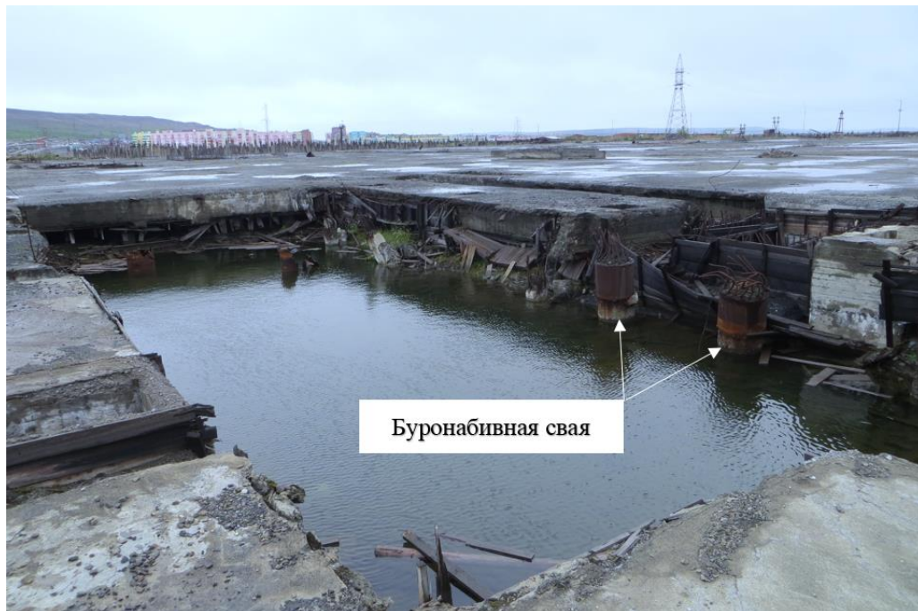
Рисунок 1.5 – Буронабивные сваи на недостроенной фабрике в Кайеркане
